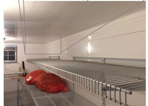
Un refrigerador equipado apropiadamente resulta en una instalación limpia tanto visual como físicamente. Note el uso de secciones recortadas para cerrar brechas en las esquinas.
